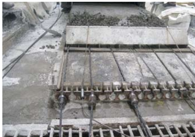
Рис. 2. Формовка линии многопустотных плит со смешанным армированием
